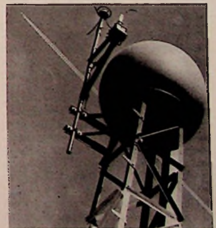
Radargerät »Corail« zur Flughafenüberwachung (Foto: LCT/ITT)
